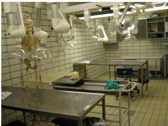
Figur 7 Sektionsstue med punktsug ved bordene.
