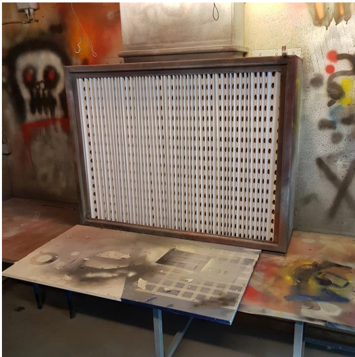
Figur 12 Udsugningarmatur i sprøjtekabinen
