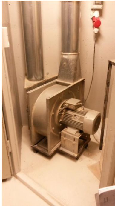
Figur 9 Motor der driver ventilationen i snedkerværkstedet
