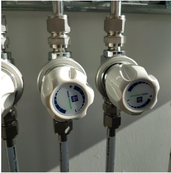
Figur 3 Ventiler ved indføring af gas i Teknisk Fakultet
